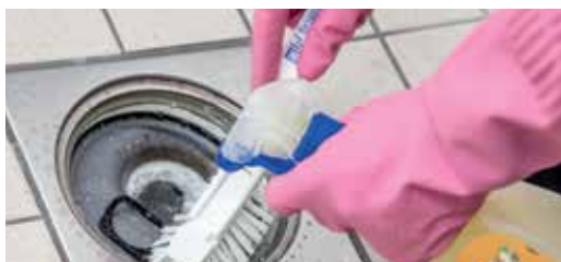
4. Suihkuta kaivoon ja kanteen puhdistusainetta. Pese vanhalla tiskiharjalla ja suihkuta puhtaaksi.
